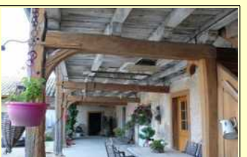
Ferme lieu-dit Villette à Saint-Georges-sur-Renon
