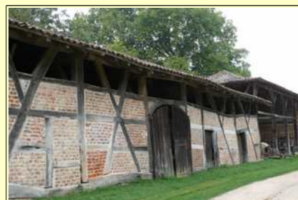
Bâtiment annexe du château de Saint-Paul-de-Varax
